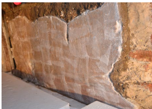
Fig. 36. Milano, via Illica-Palazzo Litta: ingarzatura dell'affresco.
