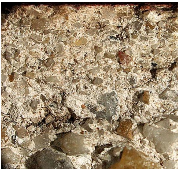
Fig. 20. Strati sovrapposti, a granulometria grossolana, di un intonaco (via Broletto-via del Lauro).
