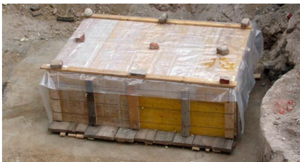
Figg. 44-46. Milano, piazza Fontana: le fasi di preparazione e imballaggio del blocco di intonaci dipinti per il trasporto dal cantiere al laboratorio di restauro.
