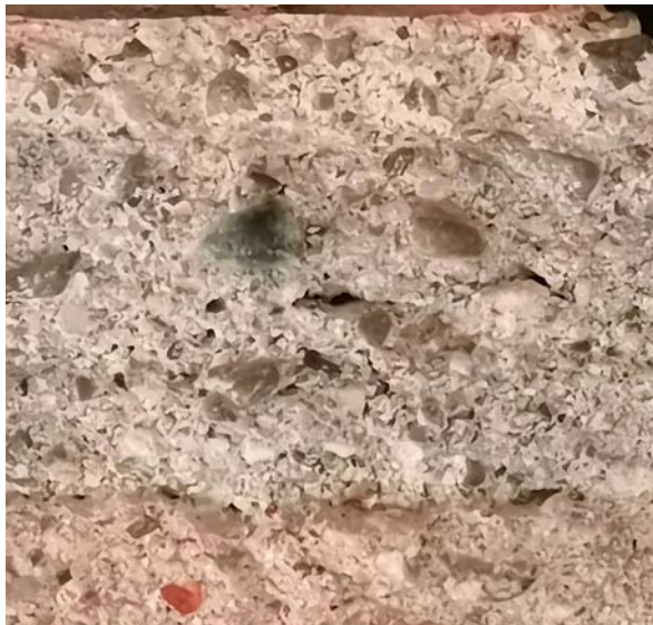
Fig. 21. Strati sovrapposti, a granulometria fine, di un intonaco (via Cappuccio 8-10).
