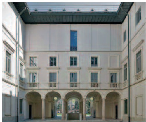
Palazzo Citterio verso la Grande Brera: Lavori 2015-2018
